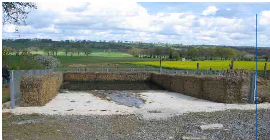
le filtre à paille : les bottes doivent être renouvelées une fois par an
