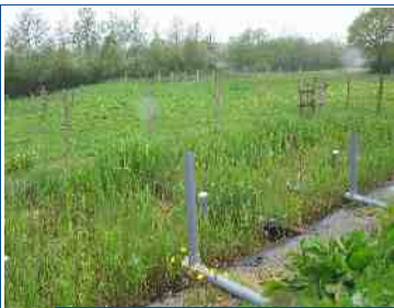
le second étage du filtre planté de roseaux
