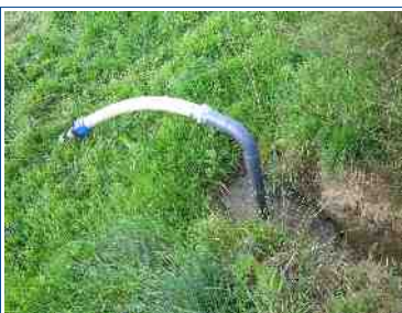
le raccord vers le tuyau percé
